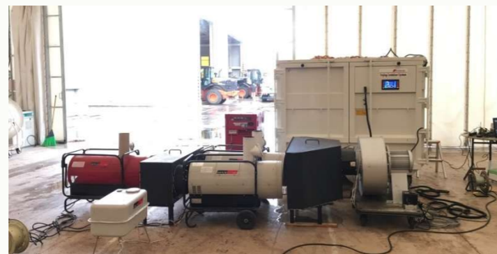
ジェットヒーターを使った乾燥試験
