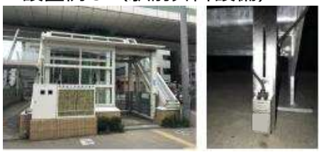
■設置例3（駅前昇降設備）
